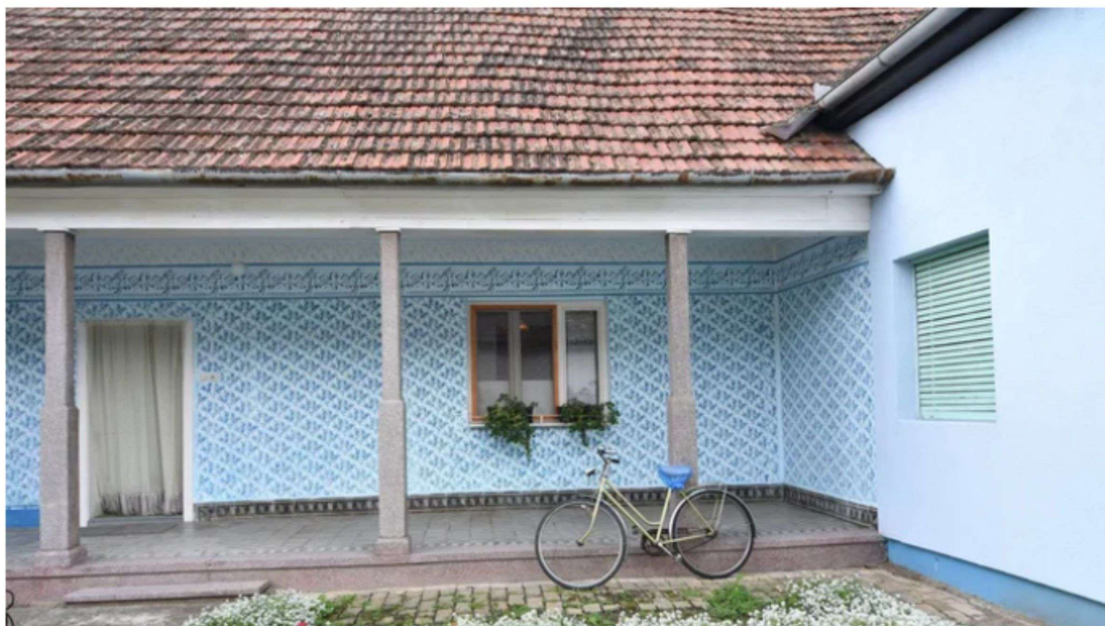
FOTO: MILAN OBRADOVIĆ
